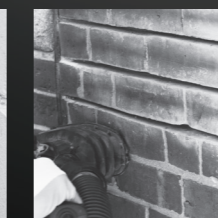
FUGENSANIERUNG
